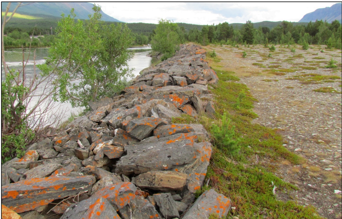
Elveforbygning i Skibotnelva i Storfjord kommune påvirker flommønsteret i indre deler av deltaet. Foto: Gunn-Anne Sommersel
